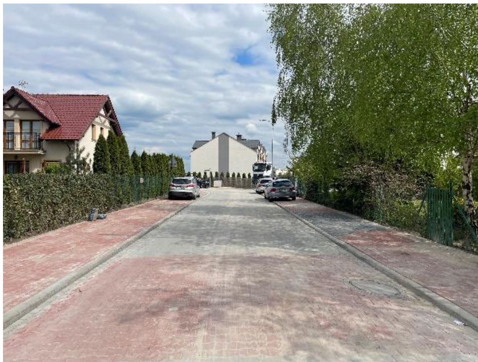
Fot. 7 Przebudowa ulicy Lawendowej w Gowarzewie – etap III
