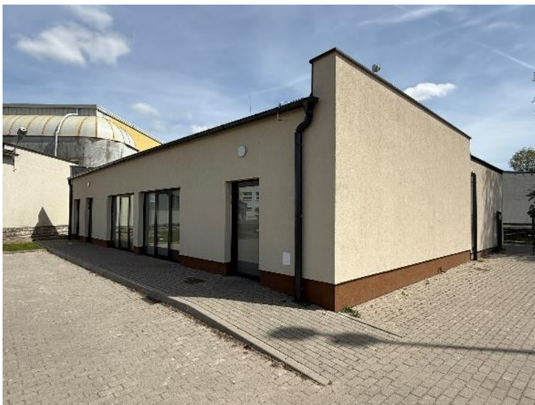
Fot. 20 Budynek szatniowo-sanitarny przy stadionie gminnym
