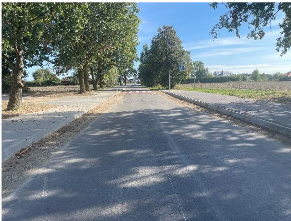
Fot. 8 Budowa drogi pieszo rowerowej do Szewc
